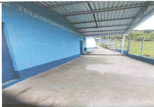
Foto 4: Vista de la entrada al aula remozada.
