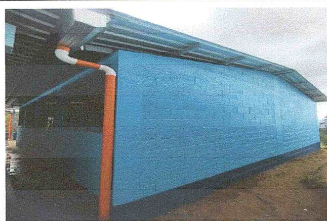
Foto 4: Vista de la parte exterior del aula
