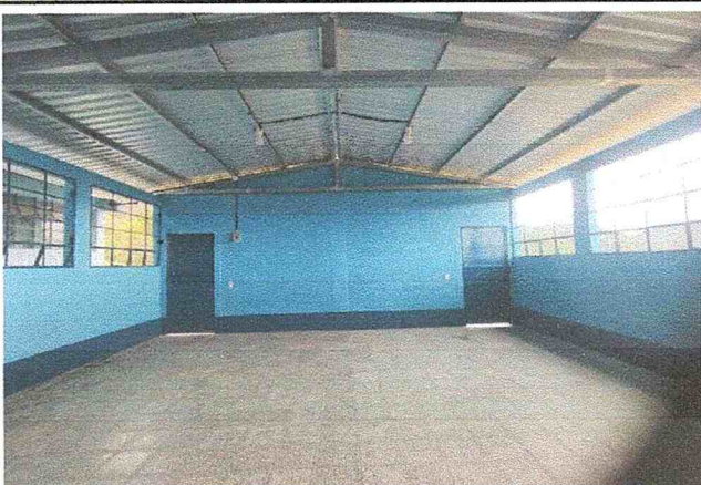
Foto 3: Vista del lado interior del aula.
